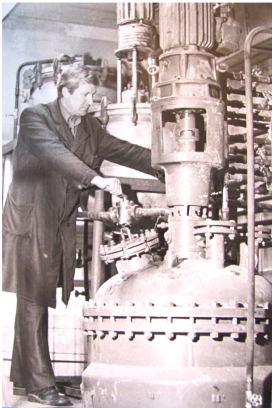
Завершение монтажа основной ферментационной установки емкостью 650 литров
